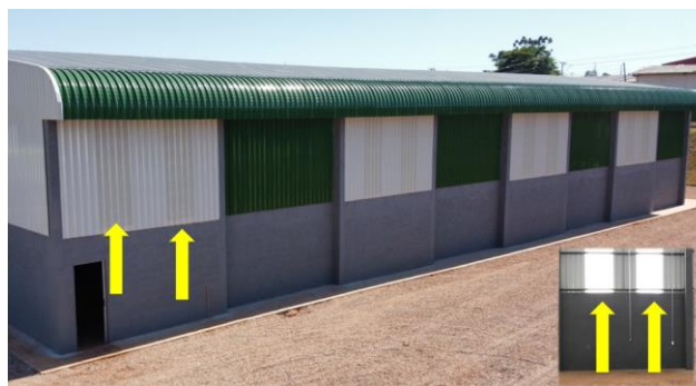
Figura 2 - Exemplo de colocação de telha translúcida nas laterais do barracão;
