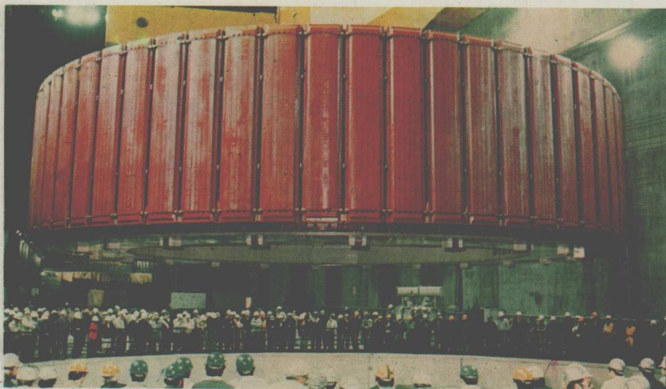
Descida ao poço de componentes da unidade geradora nº 3, setor 50 Hz.
