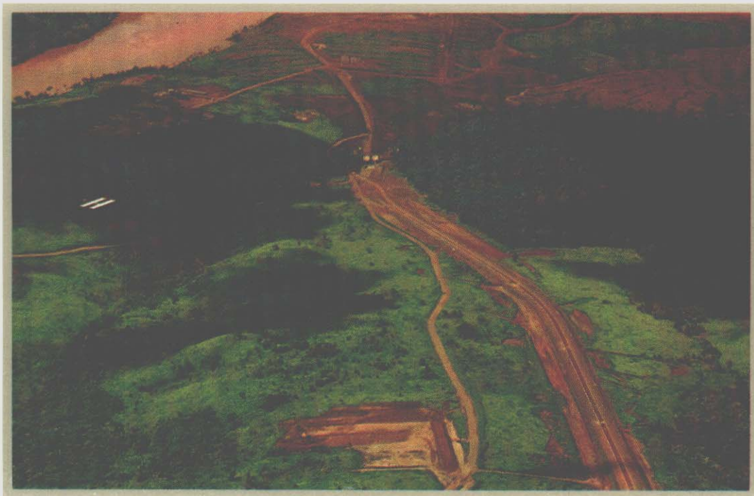
Estrada de acesso - Foz do Iguaçu/Canteiro de obras
