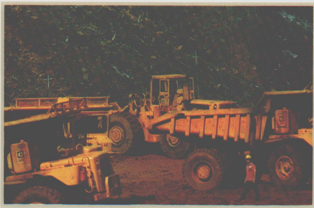
Operações de limpeza e desmatamento
