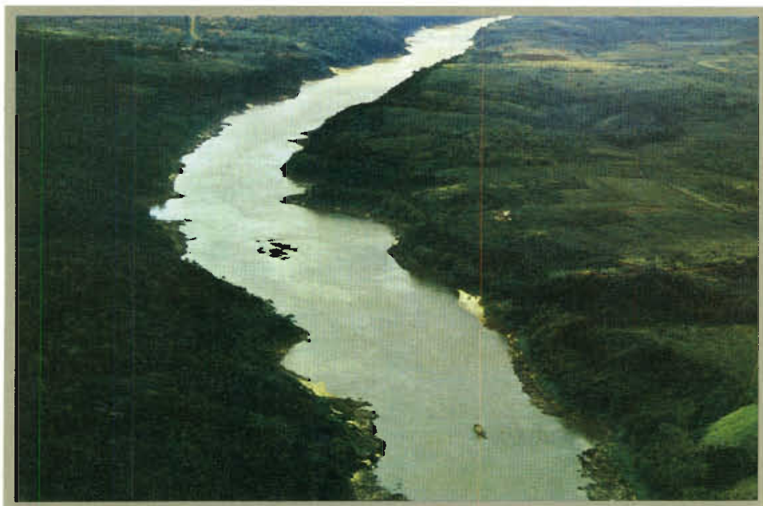
Local das obras em 31/7/75
