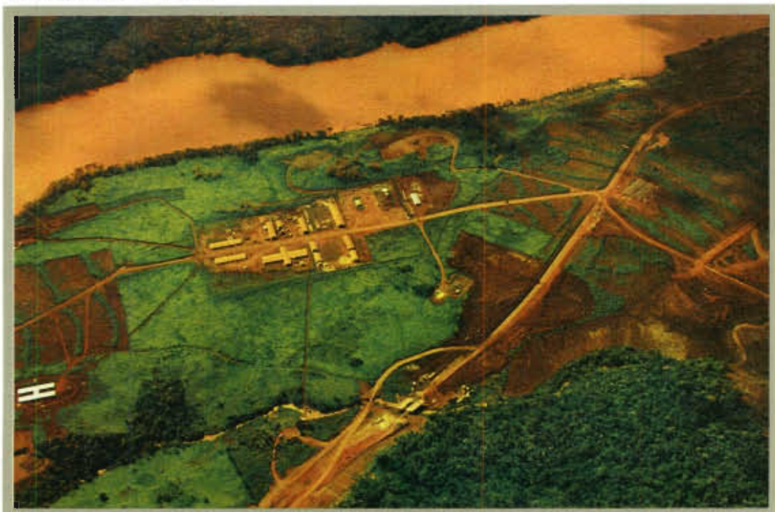
Local das obras em 31/12/75
