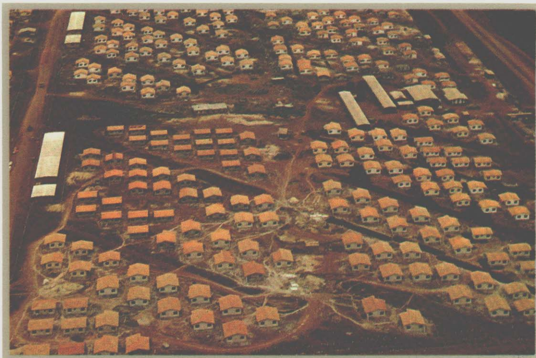
① Margem esquerda - Conjunto habitacional - 31/12/75
